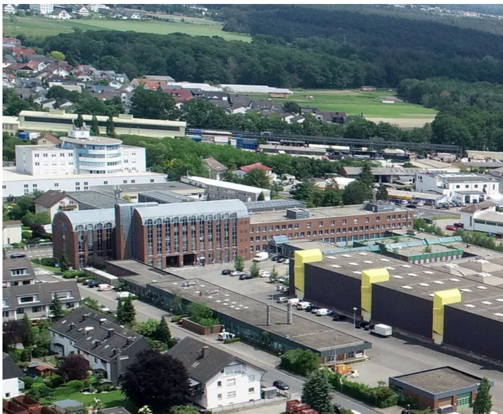
Luftbild von Südwesten
