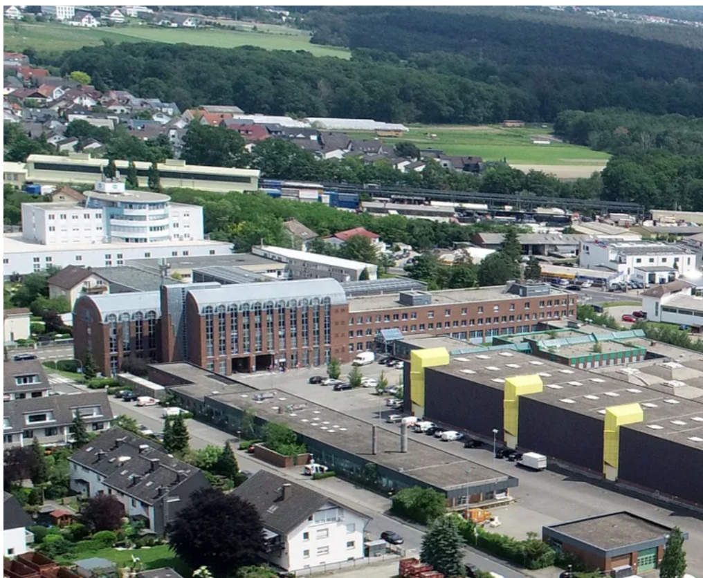
Luftbild von Südwesten
