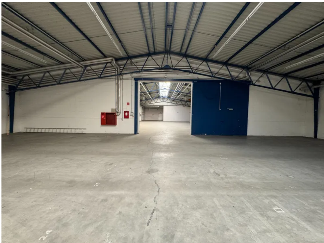
Innenansicht Halle E
